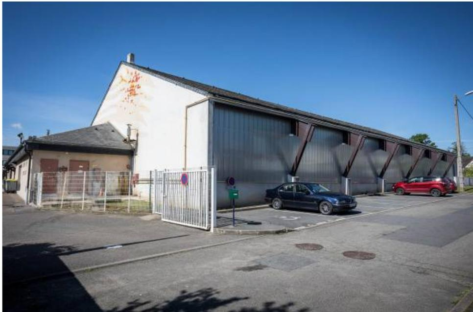
Depuis fin 2023, l'équipement est fermé en raison de la charpente qui ne répond plus aux normes de sécurité. Aujourd'hui, l'architecte est désigné et les travaux se poursuivront jusqu'en septembre 2025 pour une remise en état de la charpente et de la couverture. Pose de panneaux photovoltaïques, rénovation énergétique et mise aux normes d'accessibilité sont également étudiées, ainsi que des aménagements intérieurs.
