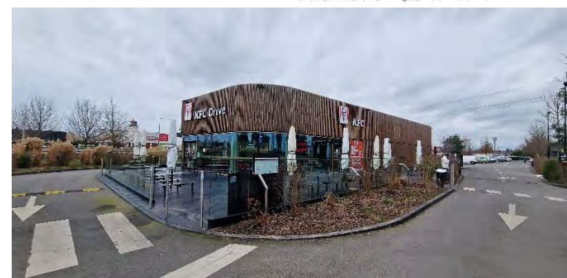
Vue d'un bâtiment de restauration isolé implanté sur la phase 1
