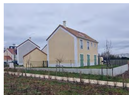
Vue des maisons individuelles implantées sur le secteur
