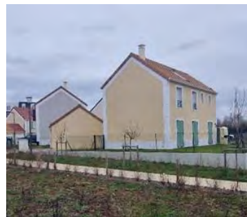
Vue des maisons individuelles implantées sur le secteur
